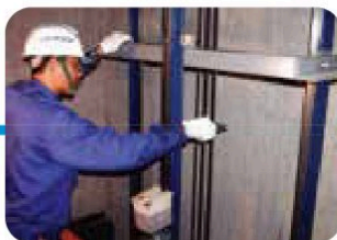
Kiểm tra hệ thống cấp tải
